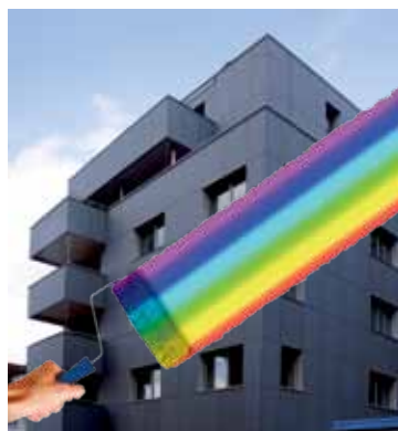
Erstes Leuchtturmprojekt – aktive Glasfassade in Zürich mit 160 kWp Photovoltaikleistung
